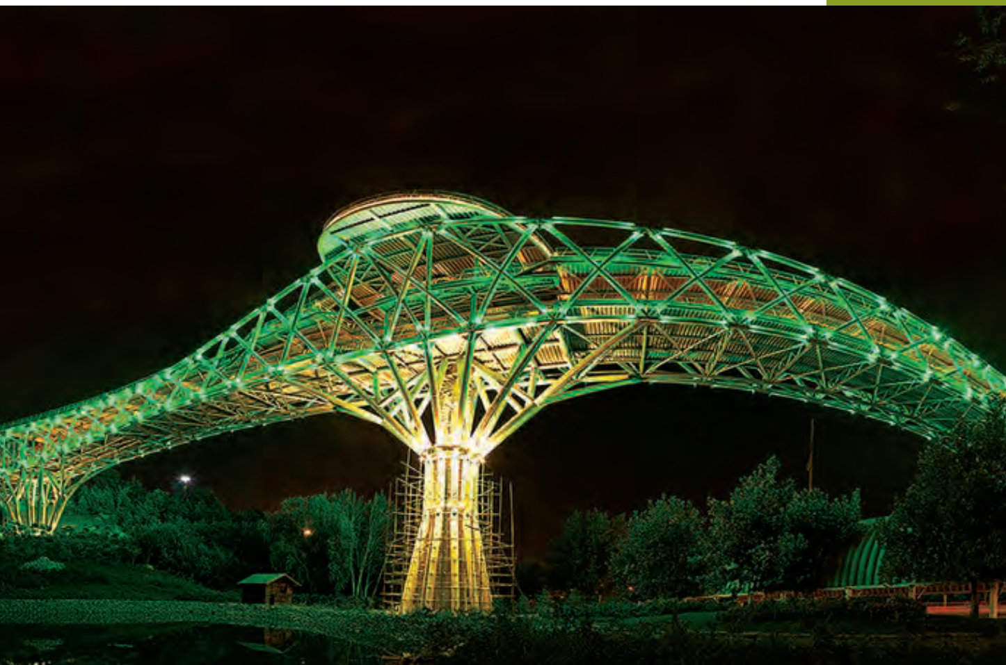
پل طبیعت / تهران
