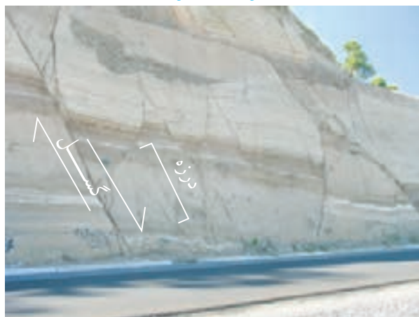
شکل ۱۵- مقایسه درزه و گسل (آذربایجان شرقی)
