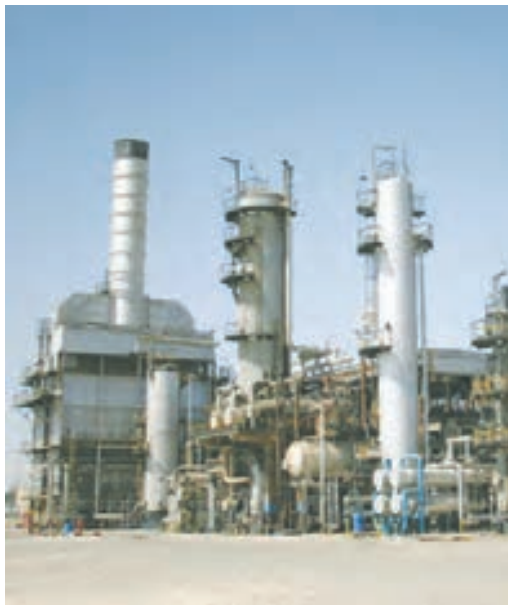
ب) نمای بیرونی برج تقطیر در پالایشگاه
