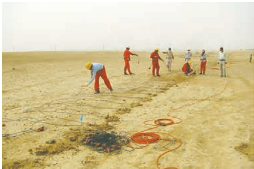
شکل ۹- انجام عملیات ژئوفیزیکی جهت شناسایی اولیه‌ی ذخایر نفت و گاز
